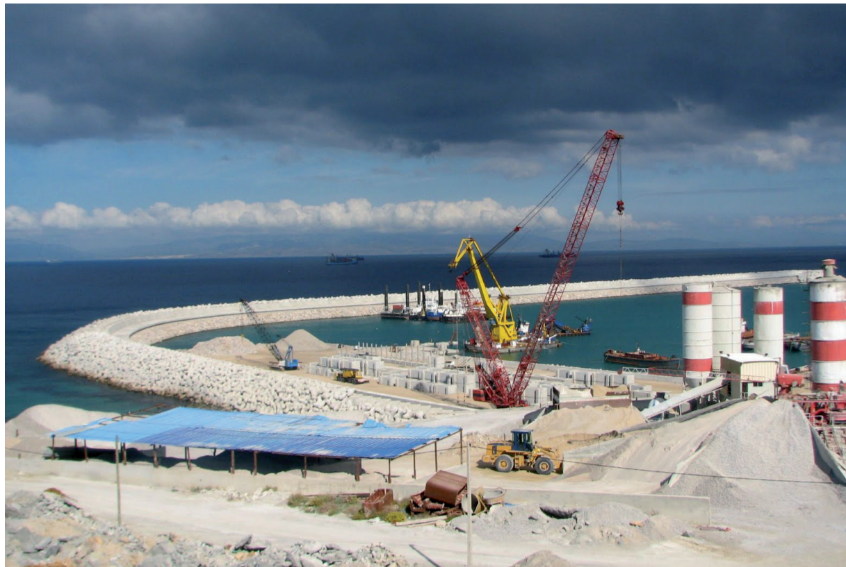
Bouygues emploie de nombreux expatriés sur ses chantiers à l'étranger. (dr)
